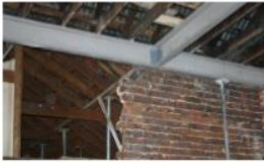
(d) Roof Beams(Keerthan, 2010)
